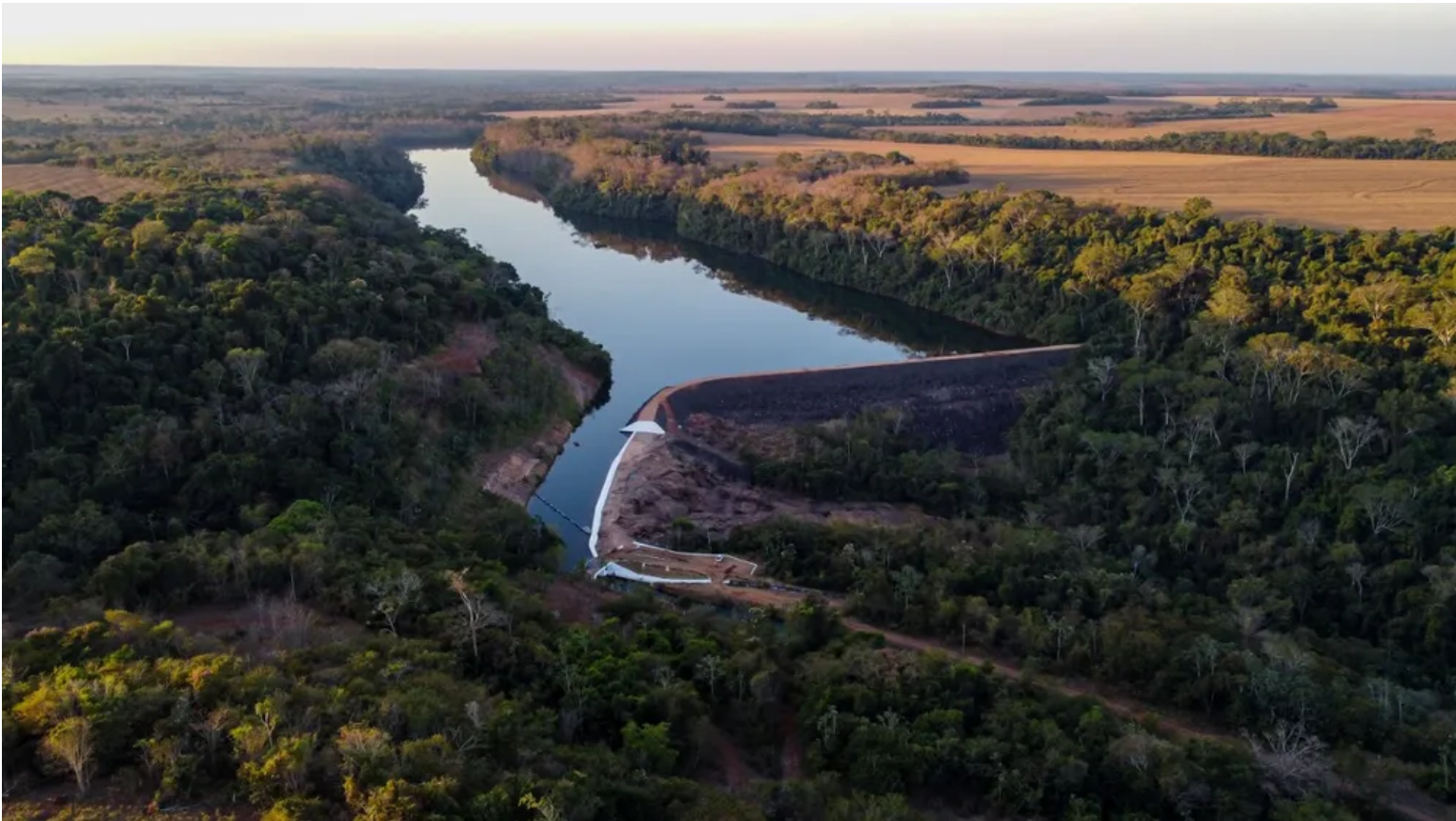
No Paraná, há 110 usinas entre PCHs e CGHs, totalizando 547,33 MW — Foto: Divulgação/IAT
